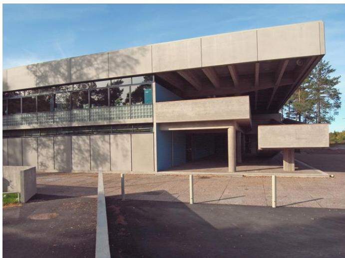
Vasemmalla: Toiseen kerrokseen nouseva luiska on veistoksellinen. Oikealla: Betonirakenteet uusittiin alkuperäisten piirustusten ja työmallien avulla. Kuvat: Timo Jeskanen.
