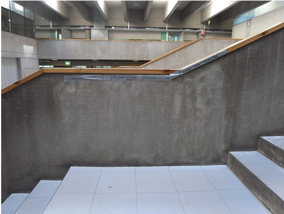
Suunnitteluaikeisia betonipinnan koekäsittelyjä. Kuva: Timo Jeskanen.
