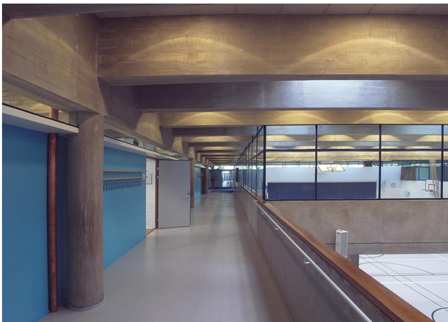
Toisen kerroksen luokkakäytävä. vasemmassa reunassa kuparinen sadevesiputki. Kuva: Timo Jeskanen.
