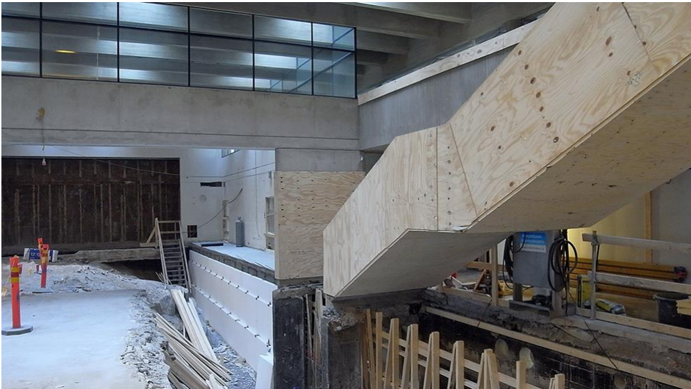
Betonipinnat suojattiin työmaa-aikana vanerilla. Kuva: Timo Jeskanen.
