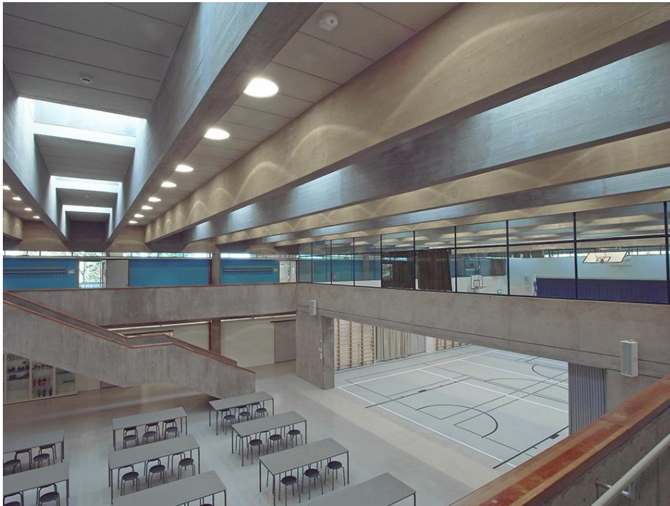
Ennen peruskorjausta liikuntasalin yläikkunoiden näköesteverhot olivat aina edessä, koska käsikäyttöisinä ne olivat liian työläitä liikuteltaviksi. Nyt verhot moottoroitiin, ja salinäkymän aukipitäminen helpottui. Kuva: Timo Jeskanen.
