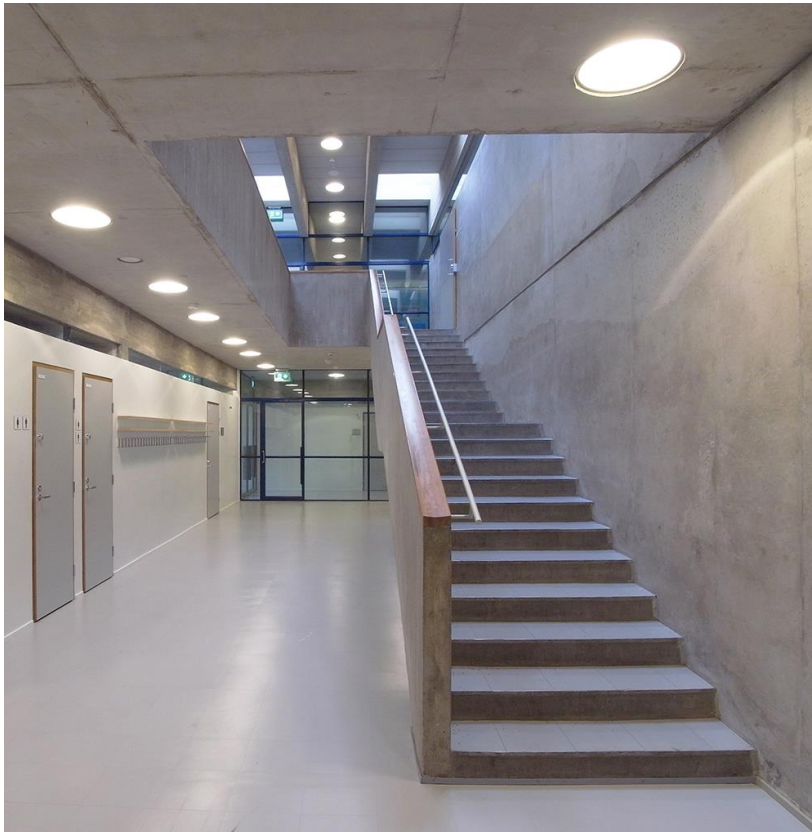
Käytävä peruskorjauksen jälkeen. Kuva: Timo Jeskanen.
