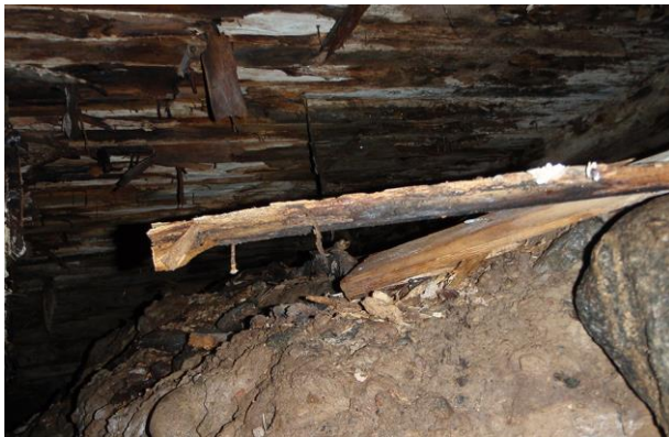
Vasemmalla Leväsjoen koulu, 1962, alapohjan lahoa muottilautaa. 1960-luvun betonialapohjien teossa käytetyt muottilaudat jätettiin usein purkamatta. Maaperän kosteus aiheuttaa vääjäämättä puurakenteiden lahoamista ja usein myös sisäilmahaittaa yläpuolisiin tiloihin. Oikealla Toijan yhteiskoulu, 1968, puhdistamaton ryömintätila. Umpinaiset onkalot voidaan havaita piirustuksista tai, kuten kuvan tapauksessa, sokkelissa olleiden pienten aukkojen kautta tähyttämällä. Kuvat: TTY, Elinkaariteknikan tutkimusryhmä, kuntotutkimukset.
