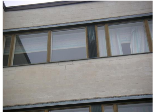
Kuva 16. Ulkoseinärakenne kantamattomalla osalla. Ikkunoiden yläpuolella on paikallinen kylmäsilta rakenteessa.
