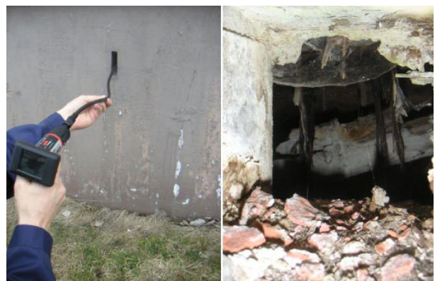
Vasemmalla Leväsjoen koulu, 1962, alapohjan lahoa muottilautaa. 1960-luvun betonialapohjien teossa käytetyt muottilaudat jätettiin usein purkamatta. Maaperän kosteus aiheuttaa vääjäämättä puurakenteiden lahoamista ja usein myös sisäilmahaittaa yläpuolisiin tiloihin. Oikealla Toijan yhteiskoulu, 1968, puhdistamaton ryömintätila. Umpinaiset onkalot voidaan havaita piirustuksista tai, kuten kuvan tapauksessa, sokkelissa olleiden pienten aukkojen kautta tähyttämällä. Kuvat: TTY, Elinkaariteknikan tutkimusryhmä, kuntotutkimukset.
