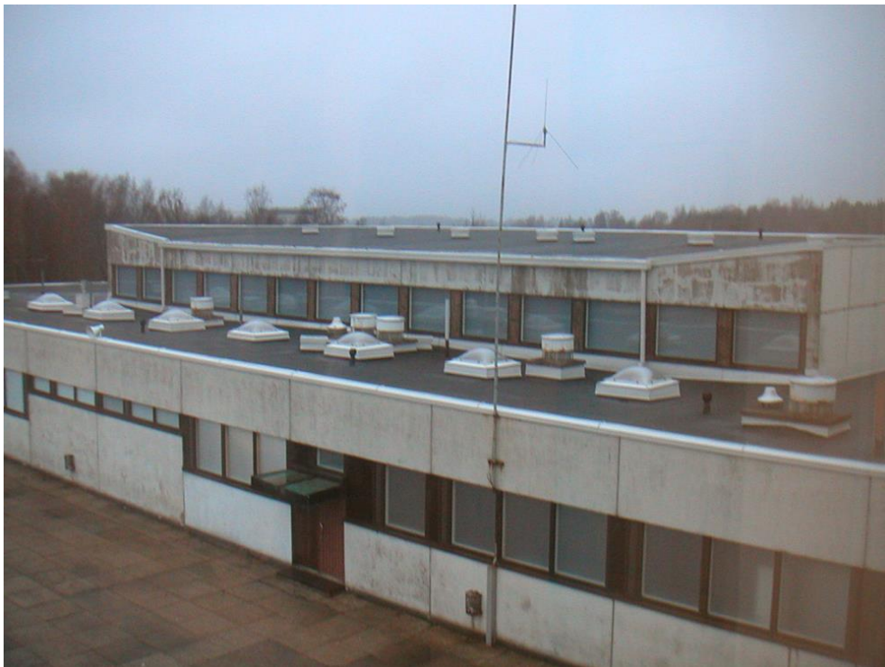
Rieskalähteen koulu, 1963, ulkokuva katolta. Rakennuksessa on loiva katto sisäpuolisella vedenpoistolla ja lukuisia kattoikkunoita. Kuva: TTY, Elinkaaritekniikan tutkimusryhmä, kuntotutkimukset.
