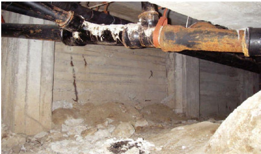
Toijan yhteiskoulu, 1968, puhdistettu ryömintätila. Kuvan onkalotilasta oli kaksi vuotta aiemmin poistettu lahoja muottilautoja ja tilan kuivausta oli parannettu. Lopputulos oli hyvin siisti lähtötilanteeseen nähden. Viemärien ikääntyminen kasvaminen aiheutti vuotoriskiä ja sen toteutuessa uusia ongelmia. Kuva: TTY, Elinkaariteknikan tutkimusryhmä, kuntotutkimukset.
