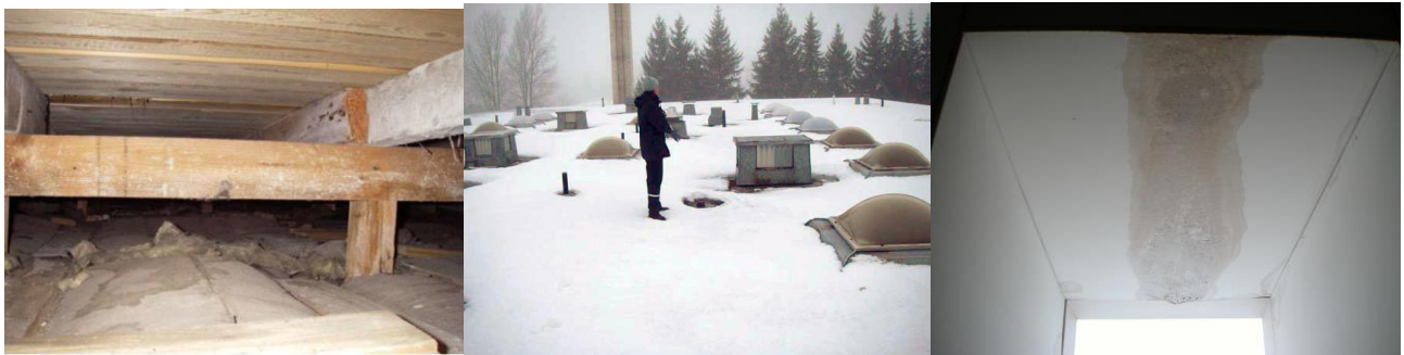
Kuvat vasemmalta oikealle: Pellonpuiston koulu, 1968, B-puoli, vesikaton alapuolinen tuuletustila. 1960-luvulla loivat katot toteutettiin usein puukorotuksina ja mineraalivillaeristeisinä. Tilan mataluuden takia tutkiminen ja korjaaminen vesikattovuodon jälkeen oli hyvin rajoitettua. Pellonpuiston koulu, 1968, B-puoli, vesikatto. Suhteellisen pienen koulurakennuksen katolla olleet 18 kupuikkunaa ja yhteensä 53 läpivientiä olivat aiheuttaneet toistuvia vesivuotoja. Rieskalähteen koulu, 1963, kattoikkuna sisäpuolelta. Kattoikkunoiden vuotovauriot aiheuttavat helposti sisäilmahaittaa voimakkaan ilmankierron takia. Kuvat: TTY, Elinkaaritekniikan tutkimusryhmä, kuntotutkimukset.
