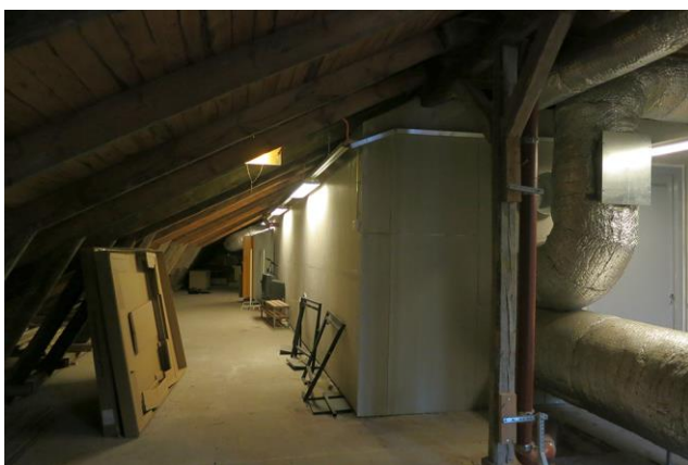
Vasemmalla Rekolan koulun konehuone ullakkotiloissa. Oikealla ilmanvaihtokonehuoneen kanavia ja kojeita. Liikaa tilaa ei konehuoneisiin yleensä jää. Kuvat: Jukka Sainio.
