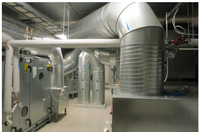
Vasemmalla Rekolan koulun konehuone ullakkotiloissa. Oikealla ilmanvaihtokonehuoneen kanavia ja kojeita. Liikaa tilaa ei konehuoneisiin yleensä jää. Kuvat: Jukka Sainio.
