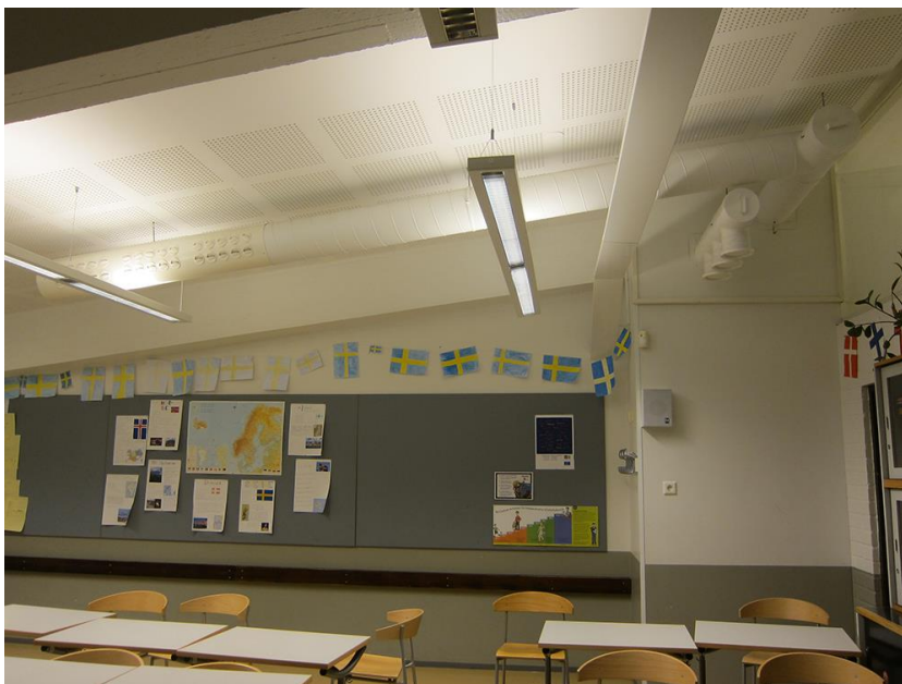
Rei'itetyt sisäänpuhalluskanavat ovat yleisimpiä ratkaisuja luokkien tuloilman puhallukseen. Näin myös Herttoniemen yhteiskoulussa. Kuva: Jukka Sainio.
