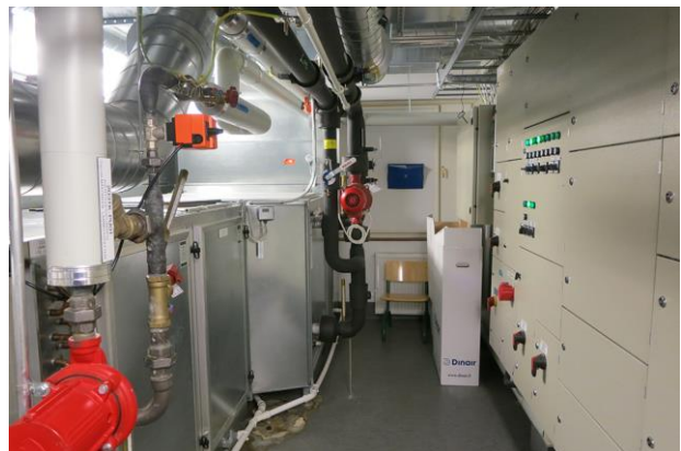
Vasemmalla Vartiokylän ala-aste. Arkkitehti Jorma Järvi, 1959. Oikealla konehuoneessa on vain tuloilmakone. Vastaava poistoilmanvaihtokone lämmöntalteenottolaitteineen on vesikatolla. Kuvat: Jukka Sainio.
