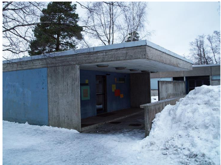
Vasemmalla: Roihuvuoren koulun pieni kerho- ja liikuntasali alkuperäisessä käytössä. Tilaan sijoitettiin uusi ilmanvaihdon konehuone sekä uusi kokoustila. Oikealla: Alkuperäisen ulko-WC:n lipan alla oli Anitra Lucanderin seinämaalaus. Puretun rakenteen on korvannut uusi betoninen katosrakenne. Kuvat: Mikko Lindqvist, Helsingin kaupunginmuseo.
