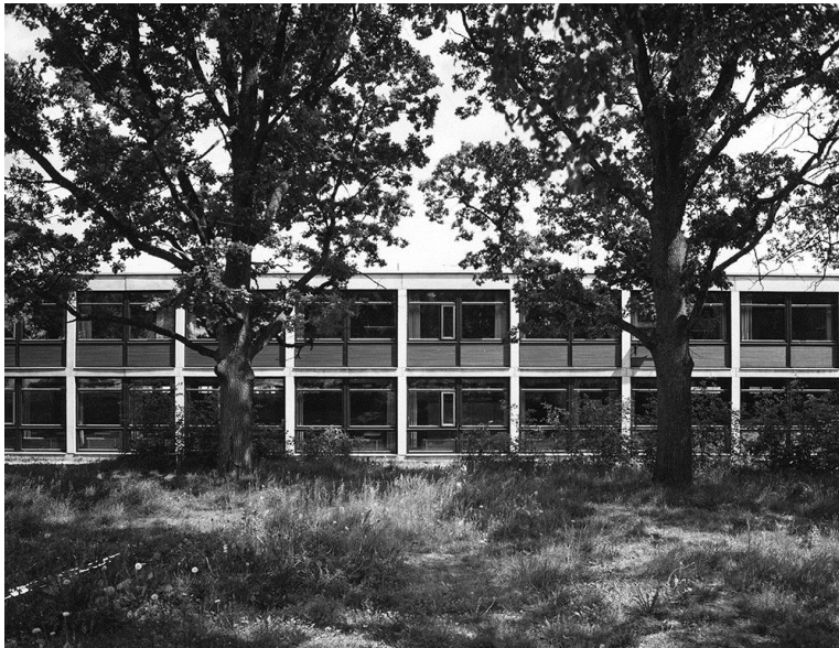
Osmo Sipari ja Kyösti Venermo: Vapaaniemen yhteiskoulu, Espoo 1970. Julkisivussa näkyy pilari-palkki -runko. Kuva: Simo Rista. MFA.
