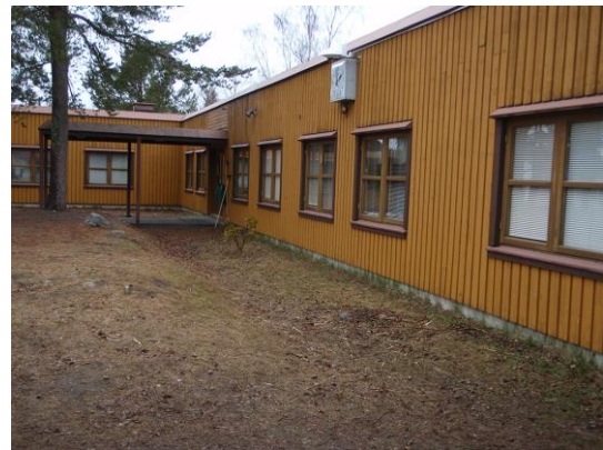
Vasemmallä Hervannan lukio, 1978, ulkoseinäleikkaus. Rakennelleikkauksia betonielementtikoulusta. Kuva: TTY, Elinkaariteknikan tutkimusryhmä, kuntotutkimukset. Oikealla Kaskisten koulu, 1978. 1970-luvulla käytettiin myös paljon puuelementtirakenteisia ulkoseiniä. Kuva: Rakennusinsinööri-toimisto Jommi Suonketo.
