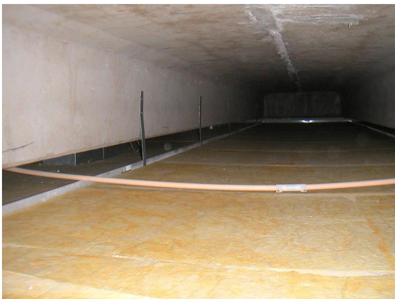
Runosmäen koulu, 1972, TT-laatta-yläpohjan ja sisäkaton väliltä. Lähinnä teollisuusrakennuksiin kehitettyjä yläpohjaratkaisuja käytettiin myös koulurakentamisessa. Kuvassa pitkin jännevalin esijännitetty TT-laatta alakaton sisältä kuvattuna. Kuva: TTY, Elinkaariteknikan tutkimusryhmä, kuntotutkimukset
