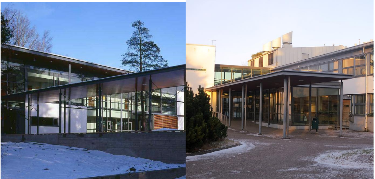
Vasemmalla Herttoniemen yhteiskoulu, 1957, arkkitehdit Erik Kråkström ja Ahti Korhonen. Laajennus ja peruskorjaus vuodelta 2001, Arkkitehtiryhmä A6 Oy. Kuva: Jukka Sainio. Oikealla peruskorjauksen yhteydessä vesikatolle rakennetut runkkanavat ja konehuone vesikatolla. Kuva: A6 Oy.
