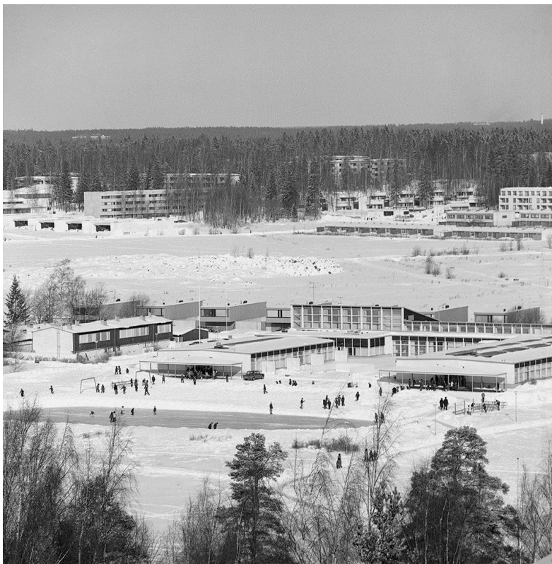
Tapiolan kansakoulu sijaitsee Silkkiniityn reunalla. Matalat luokkasiivet rajaavat väliinsä sisäpihan. Kattovalot tuovat päivänvaloa yläkoulun luokkiin ja alakoulun keskikäytävälle. Kuva: Teuvo Kanerva / Museoviraston Kuvakokoelmat.
