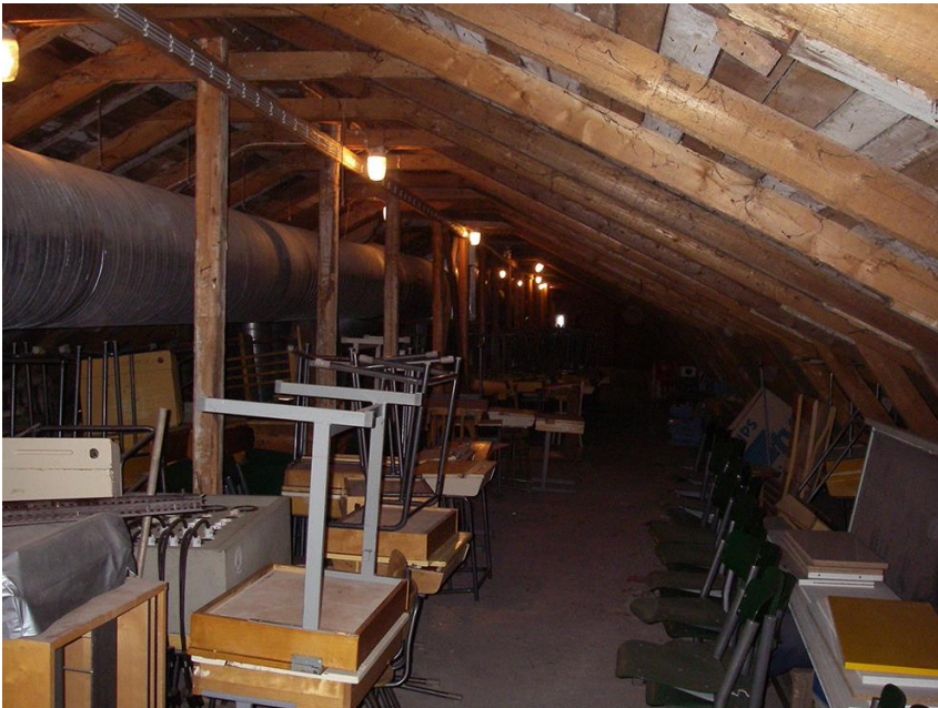
Lauttakylän lukio, 1958, B-osa. Ullakkotilat ovat palvelleet varastoina, ja myöhemmin ne ovat mahdollistaneet uusien konehuoneiden ja ilmanvaihtokanavien sijoittamisen. Kuva: TTY, Elinkaaritekniikan tutkimusryhmä, kuntotutkimukset.
