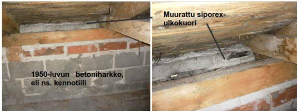
Kuva 1. Ulkoseinärakenne voitiin todeta ullakolta räystään kohdalta.
