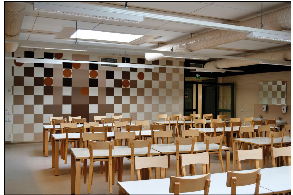
Vuonna 2016 peruskorjatun Pähkinärinteen koulun ruokalassa kasvaa koriste-maalauksen muodossa pähkinäpuu. Talotekniikkaa, kuten ilmastoinnin päätekanavia, ei ole koteloitu piiloon. Kuva: Elina Riksmän, Vantaan kaupunginmuseo, 2016.
