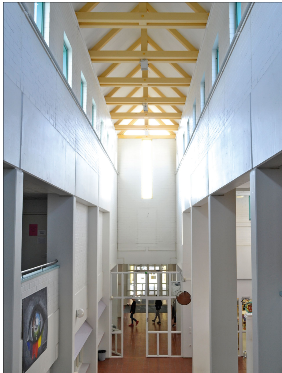
Kilterin koulun keskikäytävä ja klerestorio-ikkunanauhat. Kuva: Elina Riksmann, Vantaan kaupunginmuseo, 2016.
