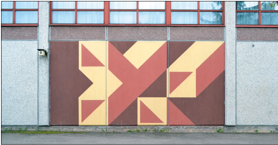
Kivimäen koulun pesubetonista julkisivua koristaa geometrinen maalaus. Kuva: Elina Riksmän, Vantaan kaupunginmuseo, 2016.
