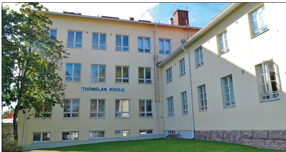
Tuomelan koulun 1930- ja 50-luvun osat erottaa helposti vaihtuvasta sokkelityypistä. Kuva: Elina Riksmann, Vantaan kaupungin museo, 2016.
